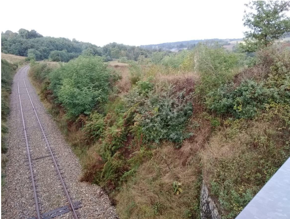
→Photo 5 : Ligne de chemin de fer (source : GERE A)
